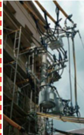
外壁塗装工事に伴う足場組立て作業中に、配電用開閉器のブッシング部分に足場用単管が接触したため、作業員の方が感電した。
